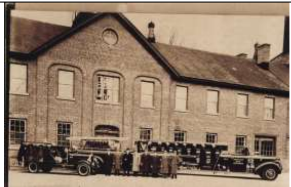
L'ancienne caserne des pompiers, façade latérale nord, début du 20 e siècle (?), Société d'histoire du Haut-Richelieu
