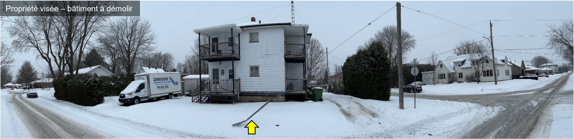
Côté opposé de l'avenue Héroux
